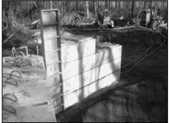
Blocks form wingwall; note CIP closure pour
