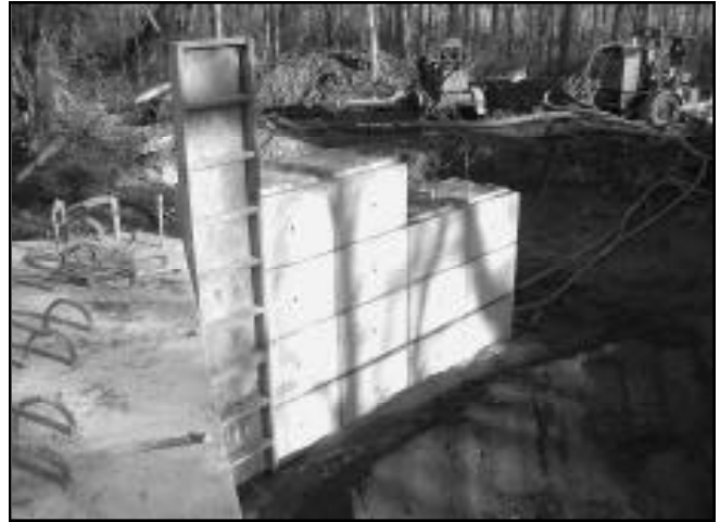
Blocks form wingwall; note CIP closure pour
